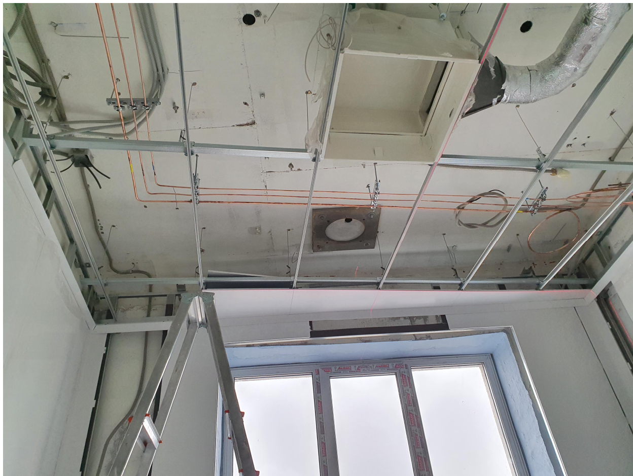
Рис.1. Металлический каркас подвесного потолка в чистых помещениях.
