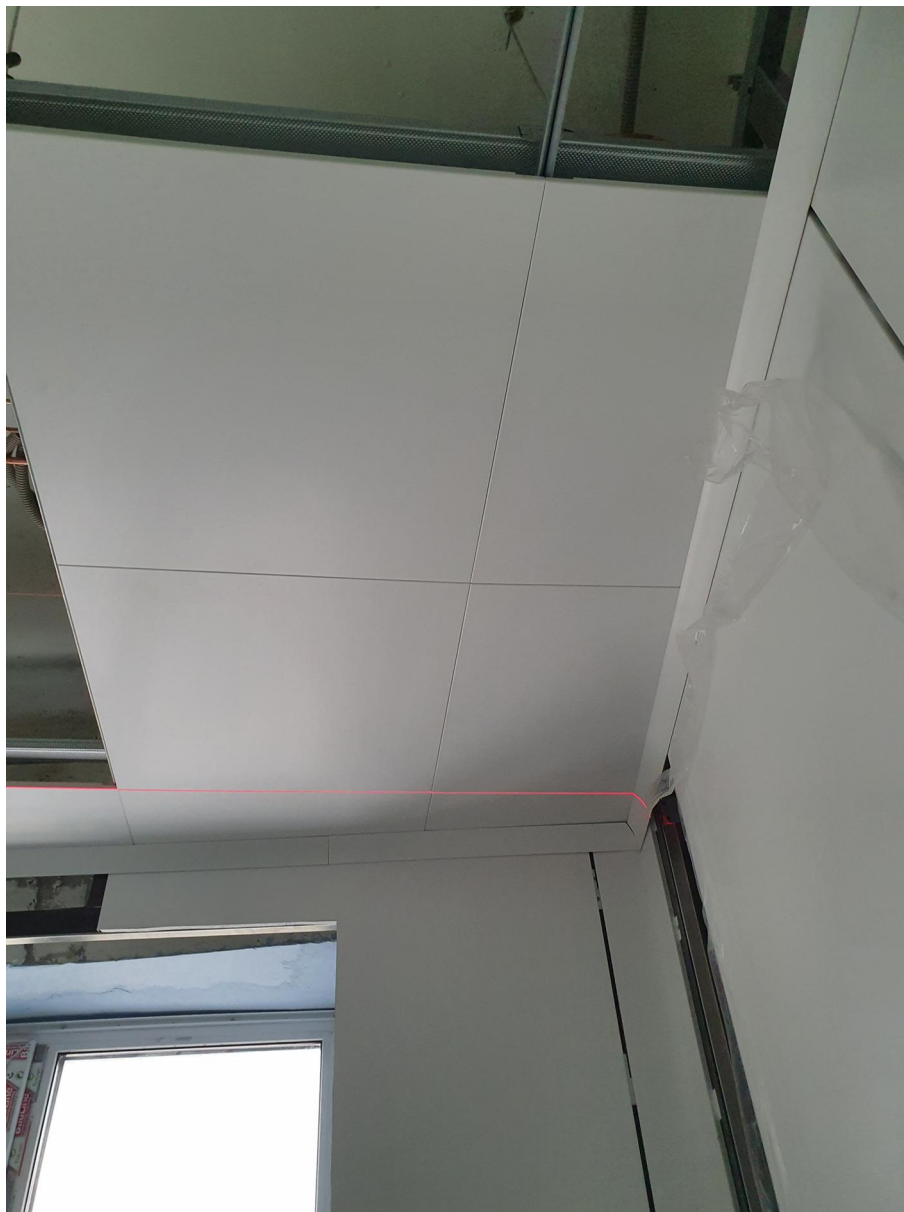
Рис.5. Монтаж скругляющего потолочного профиля и потолочных панелей.
