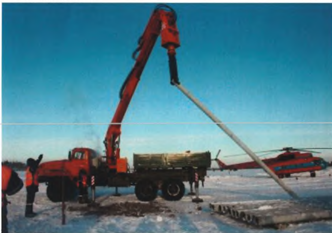
Рис.1. Погружение винтовых свай с помощью бурильно-крановой машины.
